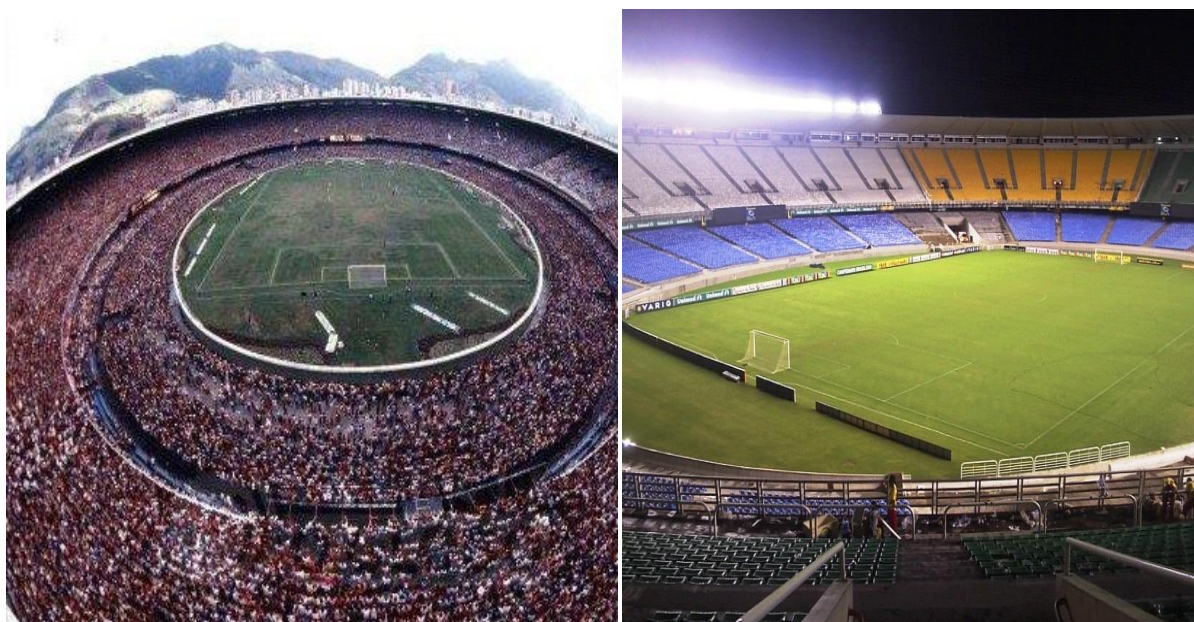
Maracanã, em 1984 (à esq) 68 , antes da 1ª reforma do estádio; e o maracanã, em 2006 (à dir) 69 , após mais uma reforma.
