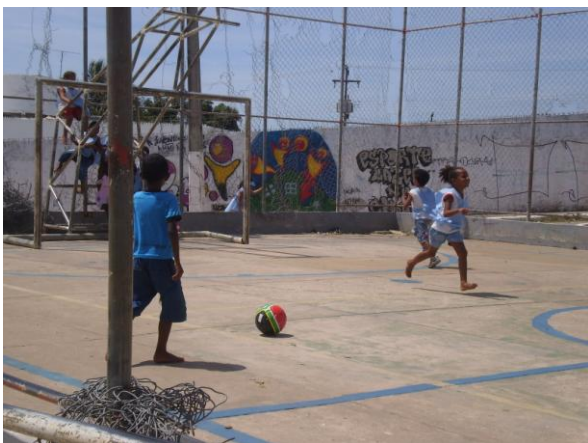
Figuras 79: o alambrado deteriorado da quadra
