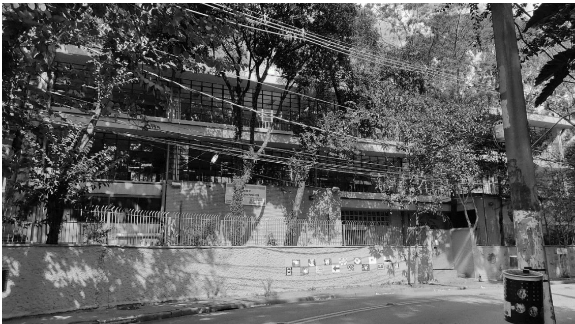
Figura 3 – Vista frontal (fachada) do prédio principal da EMEF
