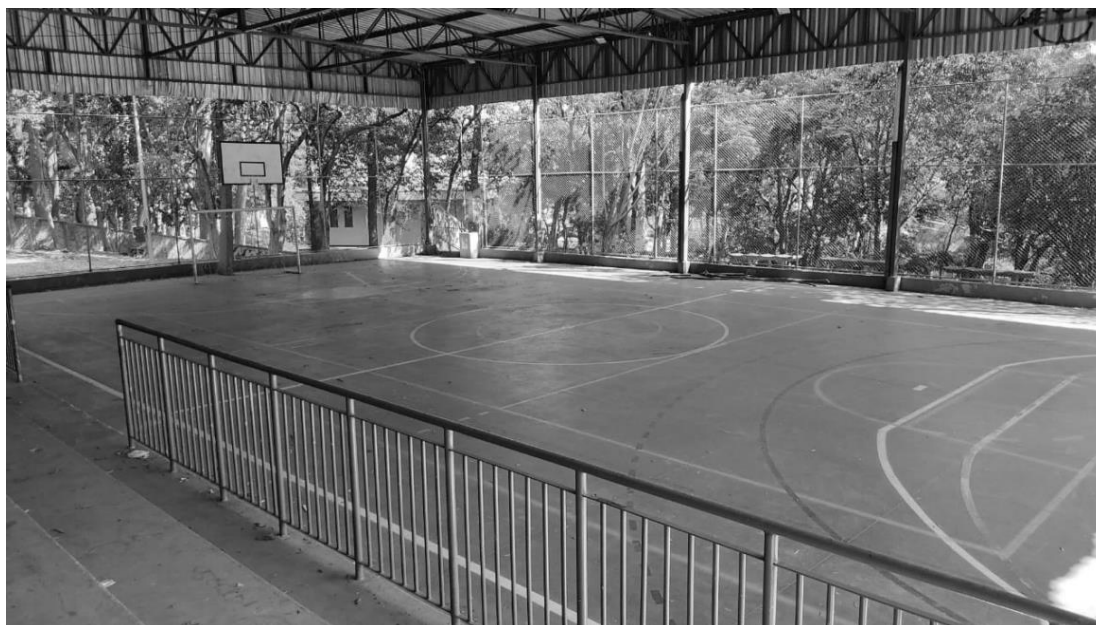
Figura 9 – Quadra externa da EMEF
