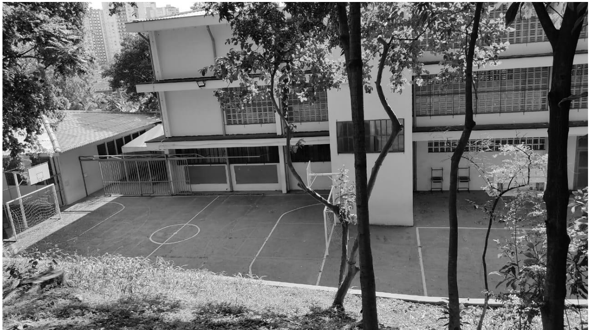
Figura 4 – Vista dos fundos (pátio) do prédio principal da EMEF
